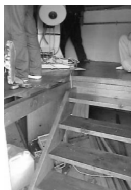
写真-15 基礎の様子 (コンクリートの角ピラーが見える)
