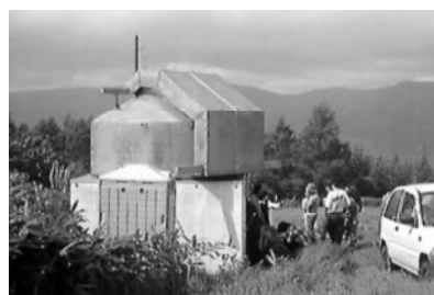
写真-14 東側より見たところ(手前はトイレ)
